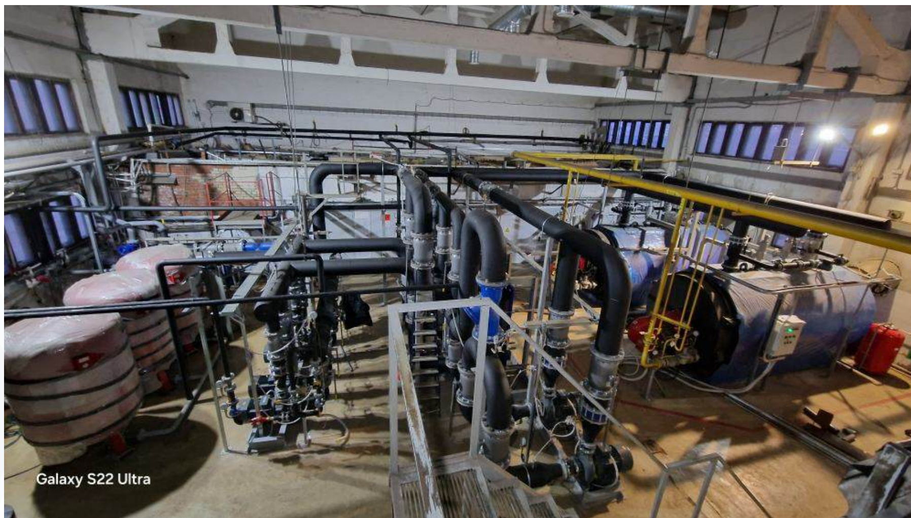
ТЕХНИЧЕСКОЕ ПЕРЕВООРУЖЕНИЕ 2024. ОБЪЕКТ "СПОРТМАСТЕР", ФОТОГРАФИИ ГОТОВОГО ОБЪЕКТА
