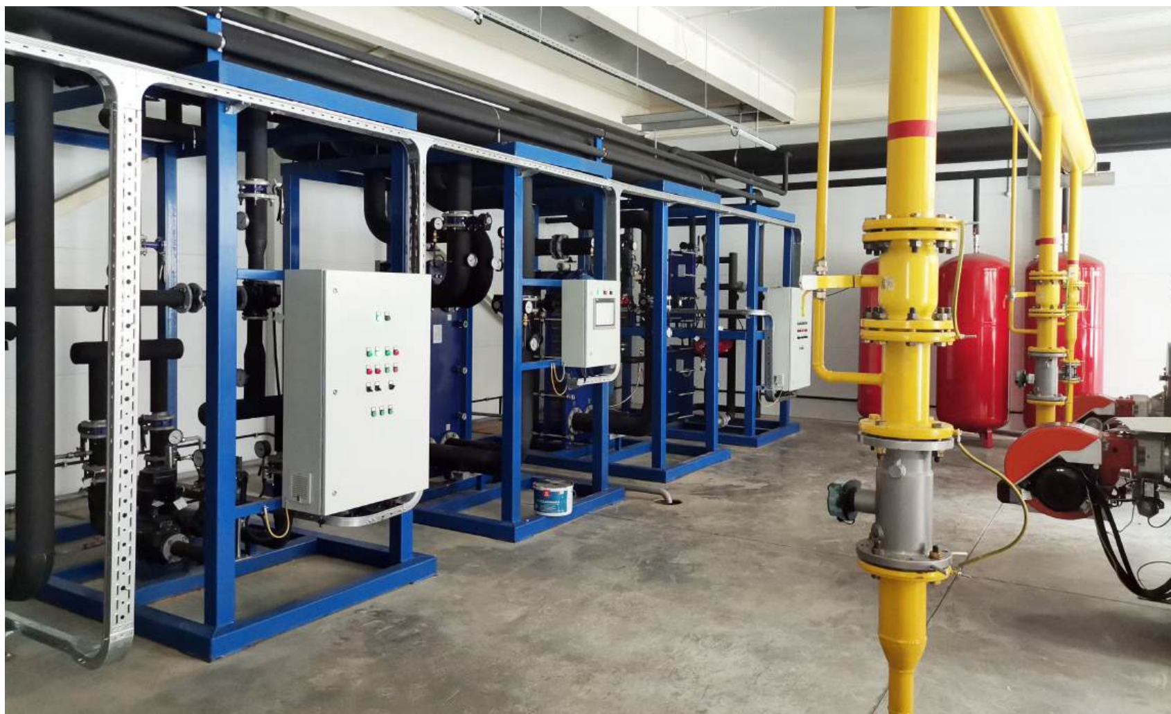
МОНТАЖ ТЕХНОЛОГИЧЕСКИХ БЛОКОВ В КОТЕЛЬНОЙ 5 МВт.
