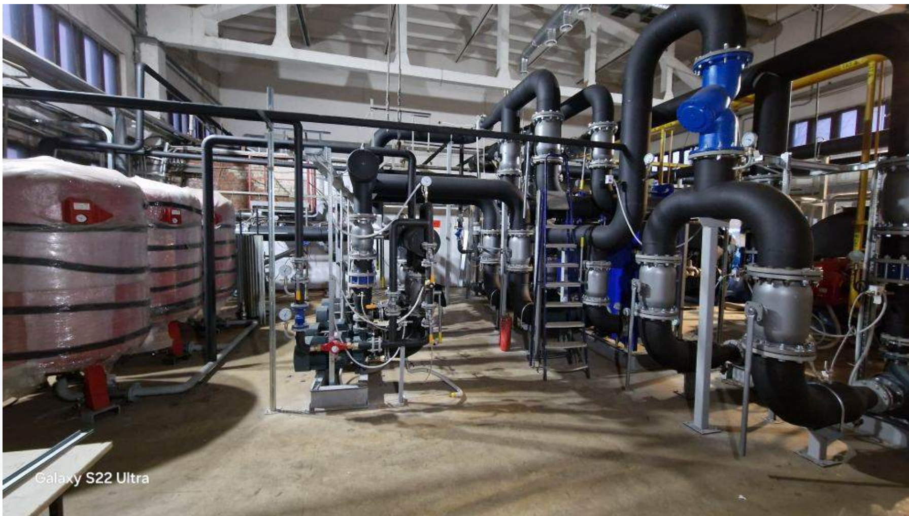
ТЕХНИЧЕСКОЕ ПЕРЕВООРУЖЕНИЕ 2024. ОБЪЕКТ "СПОРТМАСТЕР", ФОТОГРАФИИ ГОТОВОГО ОБЪЕКТА
