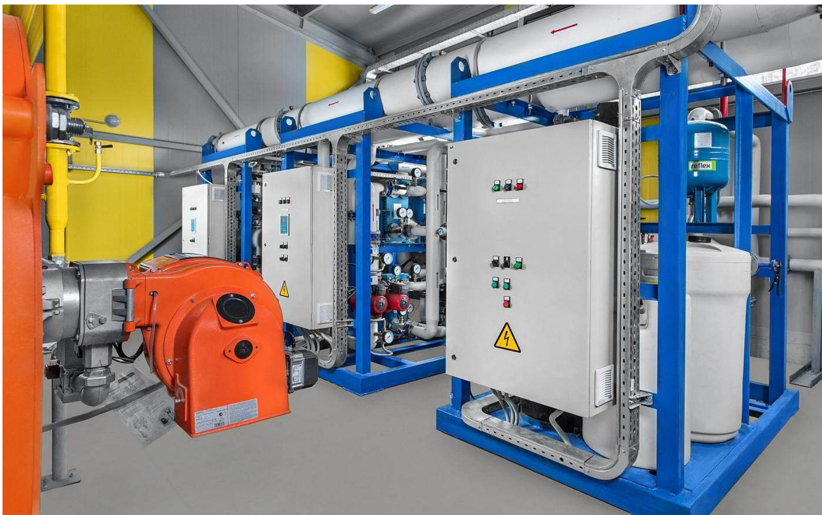
МОНТАЖ ТЕХНОЛОГИЧЕСКИХ БЛОКОВ В КОТЕЛЬНОЙ 6 МВт.
