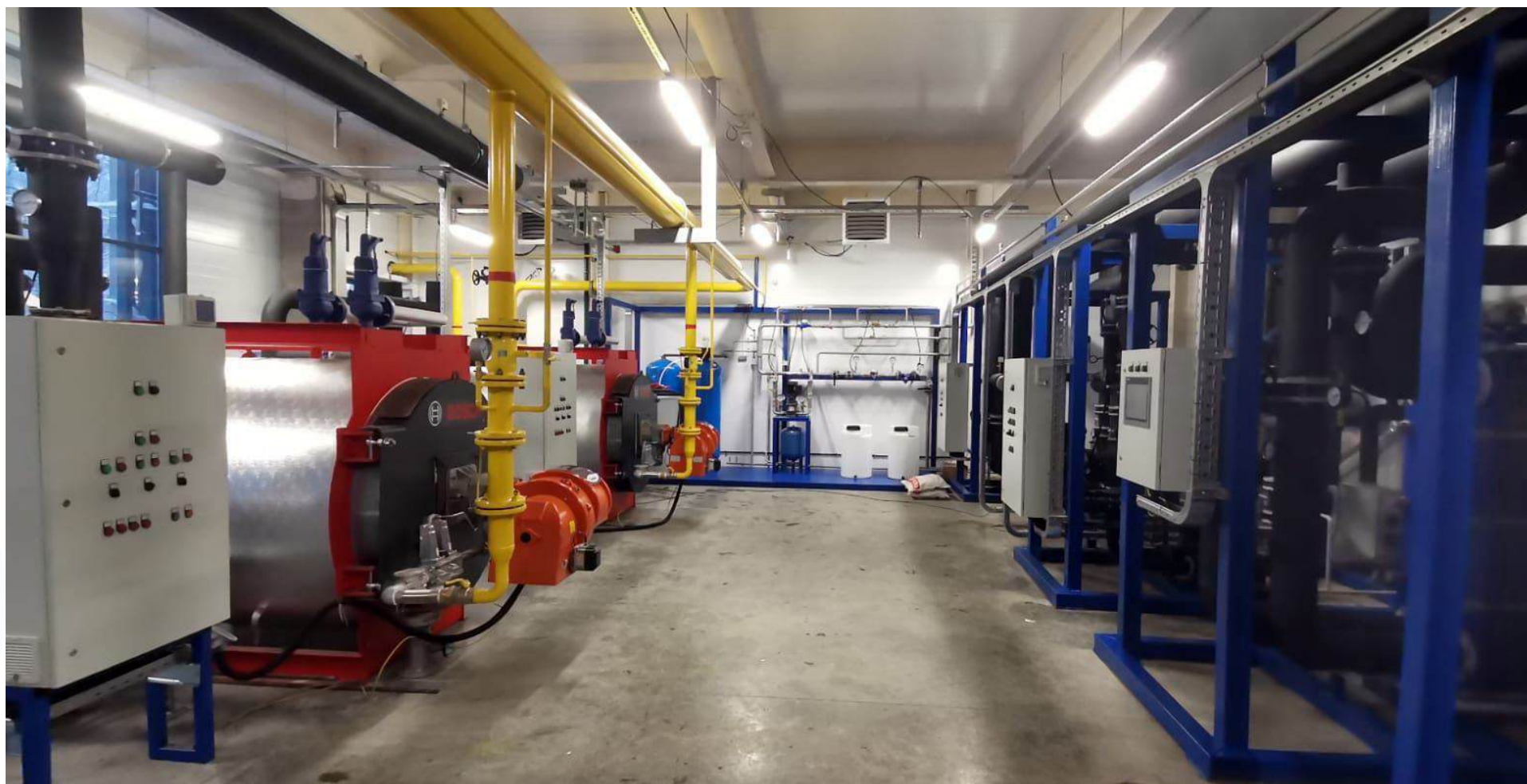
МОНТАЖ ТЕХНОЛОГИЧЕСКИХ БЛОКОВ В КОТЕЛЬНОЙ 5 МВТ.
